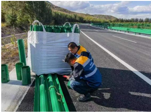
国道 305 线林东至下伙房段 项目交通安全设施检测
